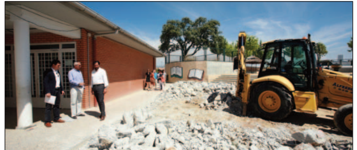
Obras en el colegio La Encina.
