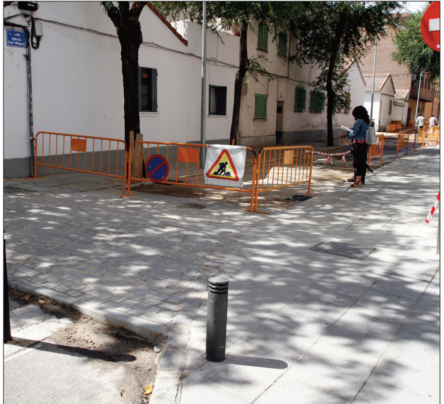
Detalle de los trabajos.
