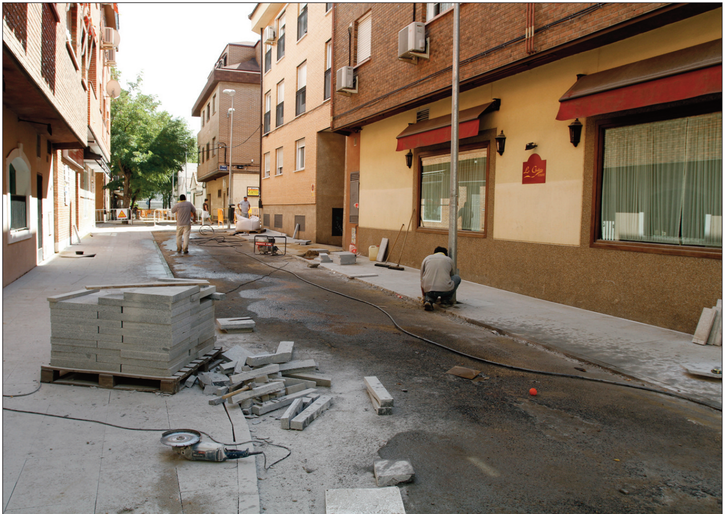
Los trabajos en la calle de la Iglesia ya están muy avanzados.
